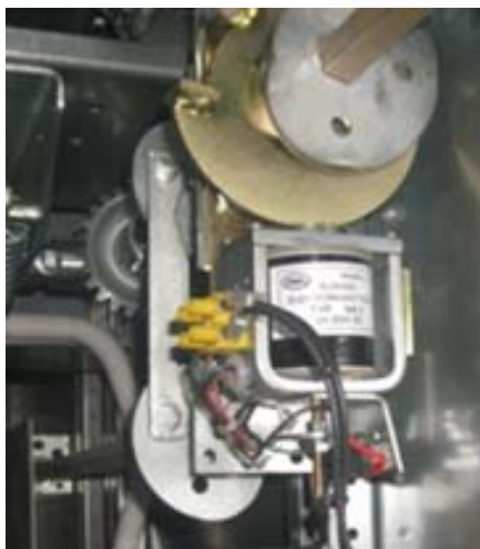
Rys. 11. Blokada elektromagnetyczna uziemnika
