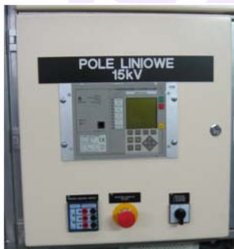
Rys. 9. Elewacja obwodów pomocniczych
