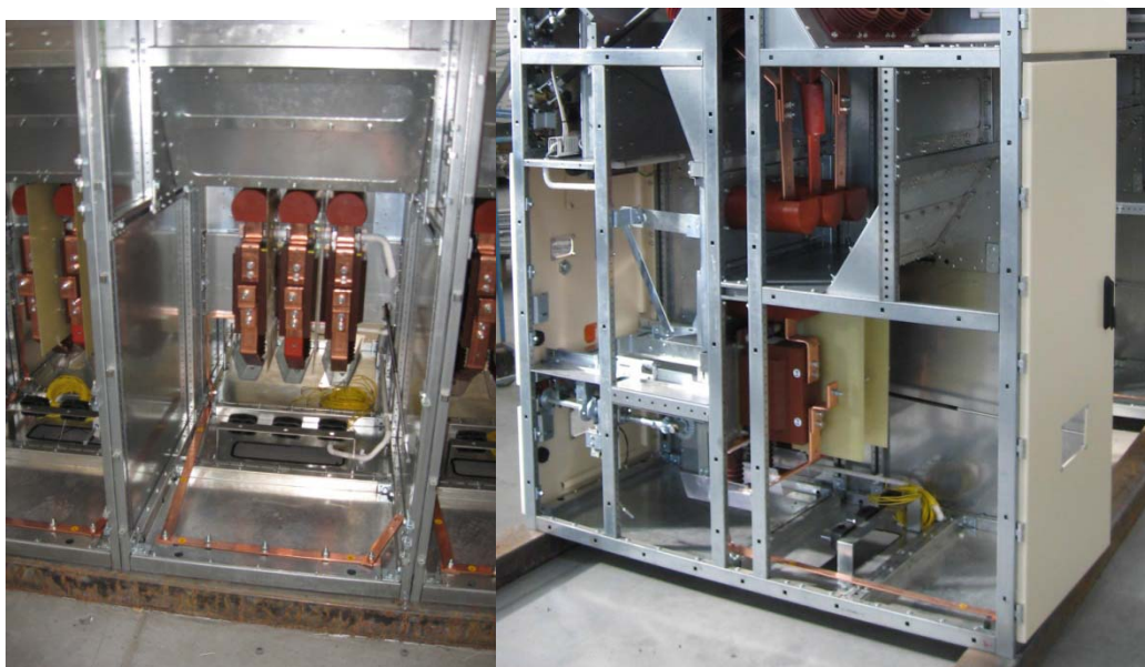
Rys. 8. Przedział przyłączowy wyposażony w uziemnik i przekładniki prądowe.
