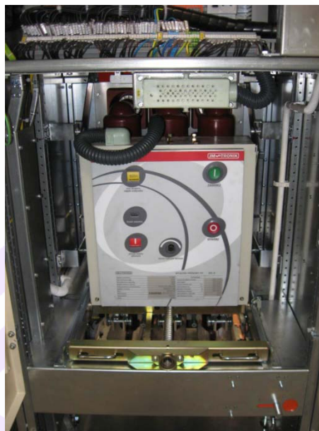
Rys. 7. Wyłącznik w polu liniowym
